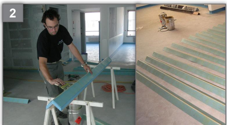
Aufschüssige Spachtelmasse oder Estrichkanten müssen sorgfältig entfernt werden! Der Untergrund muss Staub- und Schmutzfrei sein. Anstreichen der Hohlkehleleisten (z.B. mit Walze oder Spachtel) WICHTIG: Immer nach Außen streichen! (zur Vermeidung von Kleberrückständen an der Sichtkante)
