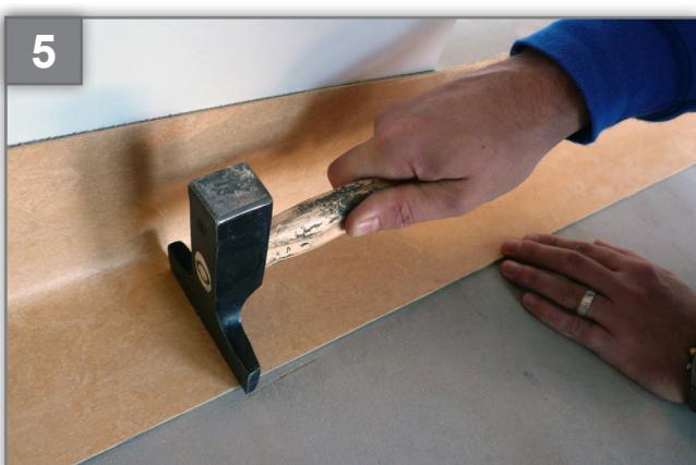
Sobald der Hochzug „ausgeklopft“ wurde, zum endgültigen Halt anreiben. Wir empfehlen gerade bei Linoleum Hochzügen den Hochzug vor der Fläche zu verlegen.
