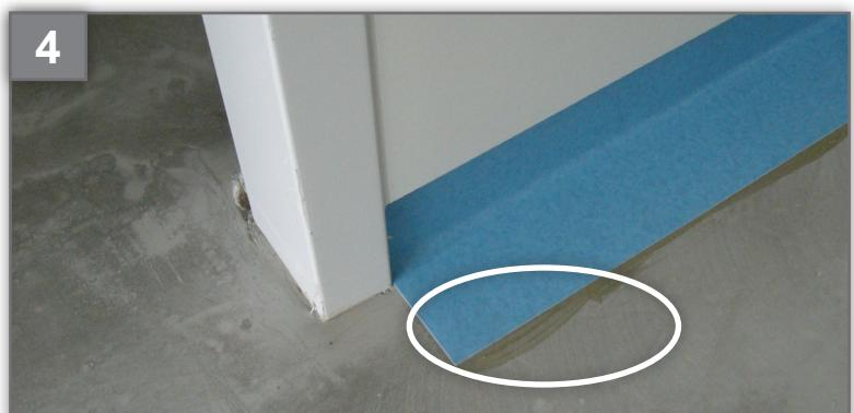
Kleberauftrag mit Filz oder Teppich (Höhe 9,6 cm) - kein Anzeichnen der Höhe mit z.B. einer Schlagschnur mehr notwendig!
