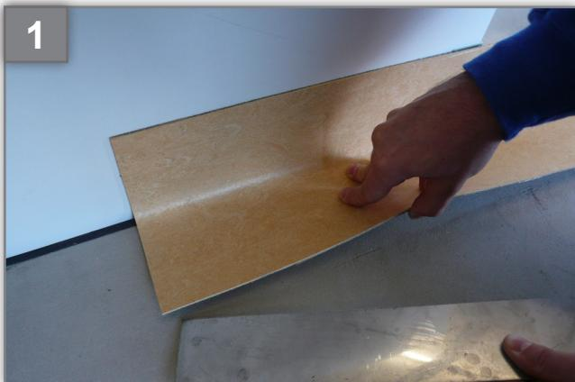
Stahllineal nach Anreiben des Hochzuges an der Wand entfernen.
