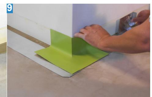
**Als Montagehilfe dient der Unterlagswinkel aus Aluminium, um ein vorzeitiges Ankleben auf einer Seite zu verhindern.**
