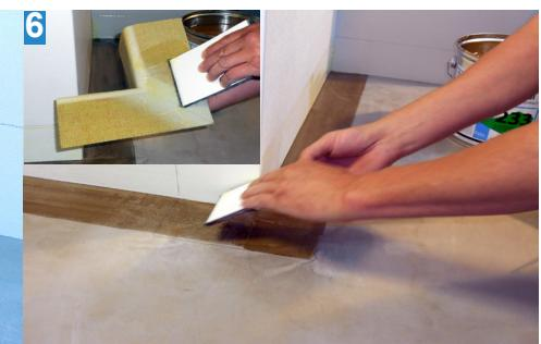
Das Anzeichnen der Umrisse erleichtert die Montage erheblich um bei bereits aufgetragenem Klebstoff Ansatzpunkte zu haben.
